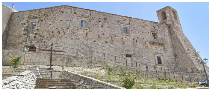
Giuliana (Pa), ex monastero della SS. Trinità, prospetto nord ritmato dai finestrini e balcone su mensole in pietra
