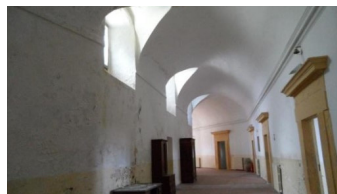
Giuliana (PA), ex monastero della SS. Trinità, salone al piano superiore con volte a crociera
